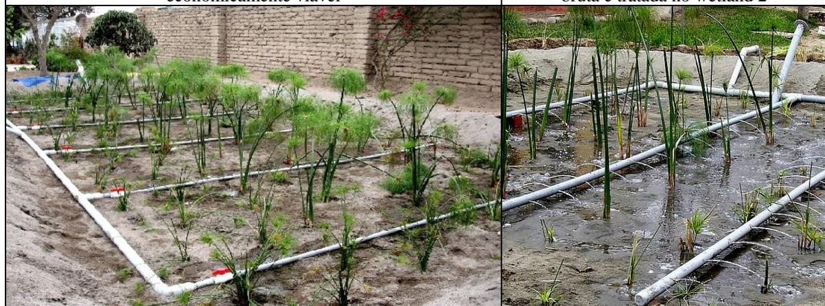
Figura 7 e 8: Wetlands para tratamento de águas negras (esquerda) e cinzas (direta) de fluxo vertical, antes de ser completado com uma camada de brita na superfície, tubos de distribuição de wetland de água negra equipados com registros, para poder deixar descansar as áreas afetadas por perigo de colmatacao
