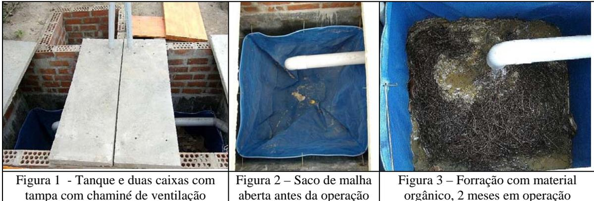
Figura 1 - Tanque e duas caixas com tampa com chaminé de ventilação
